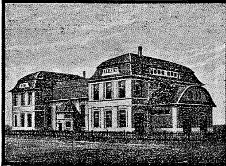
Abb. 2. Ansicht der Förderstation der Landeswasserversorgung in Niederstotzingen
